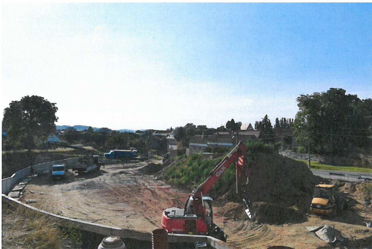
Obr.9 Výstavba multifunkčního hřiště ve Hvoždanech, termín dokončení 09/2018
